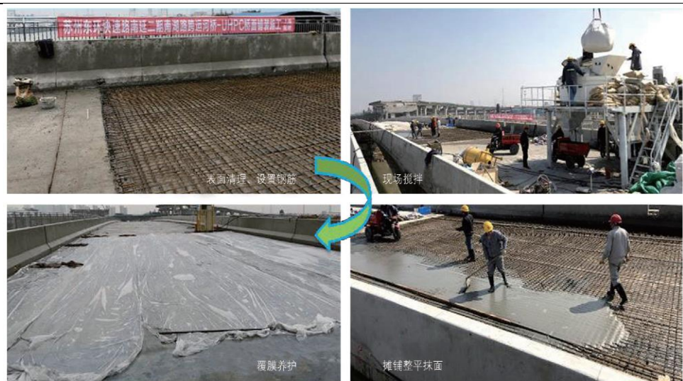
图表 25 混凝土桥面 UHPC 铺装施工示意
