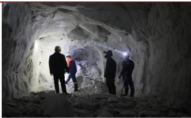
图 30 李家沟锂辉石矿矿洞掘进情况
