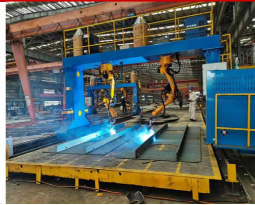
图 28 钢结构智能化生产场景
