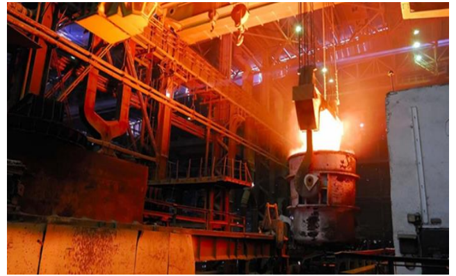
图表14 公司 NDW3 框架断路器用于沙钢集团项目
