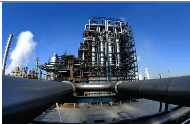
图表 64: 乙烯裂解炉管
