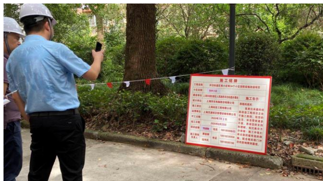
图 20：老旧小区安防设施改造项目现场
