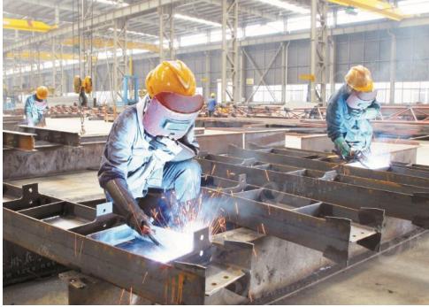
图 35: 钢结构生产车间中的人工焊接过程示例
