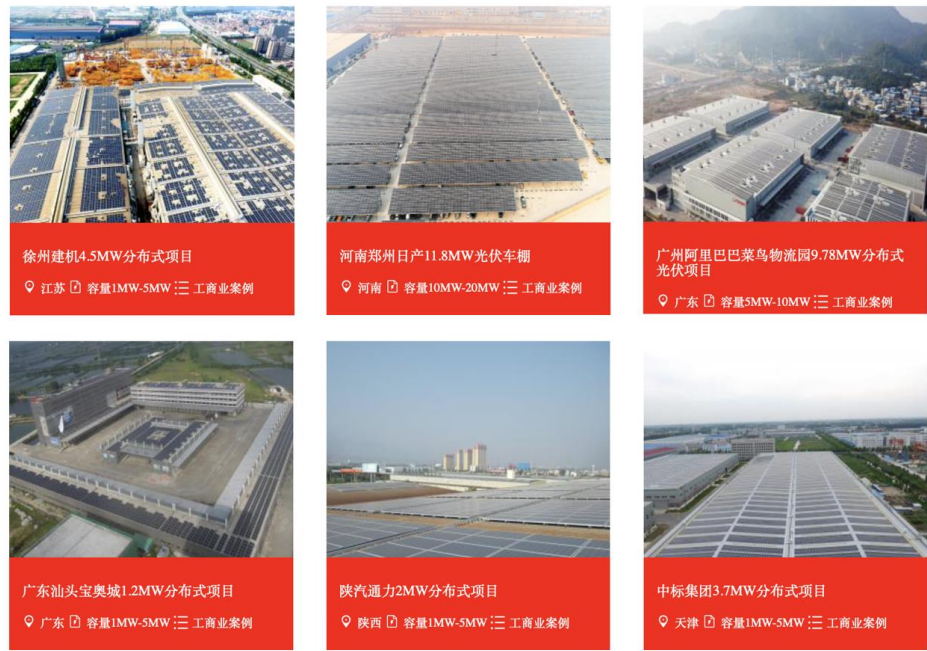
图 31：工商业屋顶成为国内现阶段 BIPV 主要应用场景
