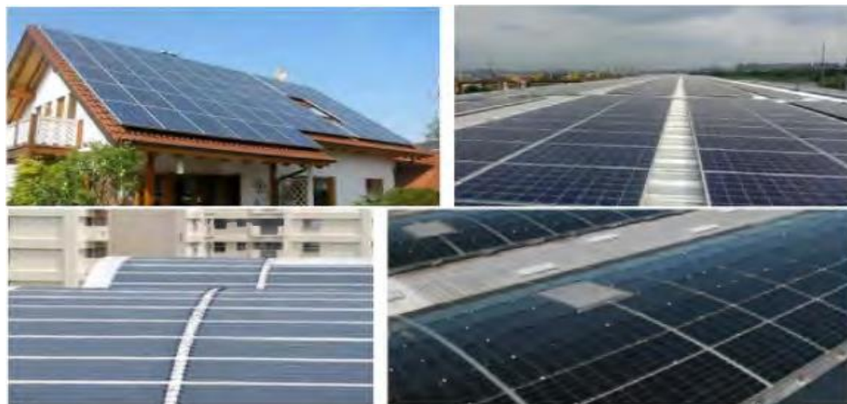
图 8：光伏组件与屋顶结合示意图
