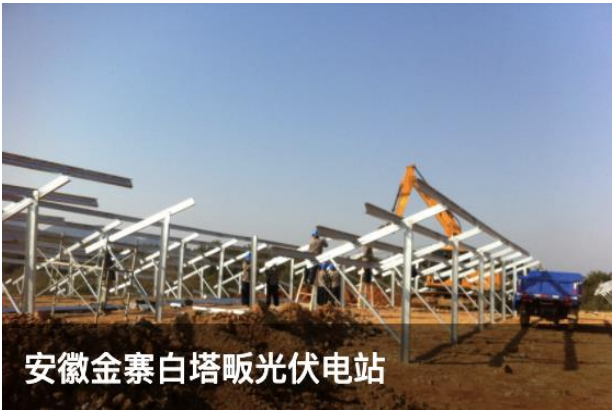
图 38：公司光伏安装项目：安徽金寨县白塔畈光伏电站
