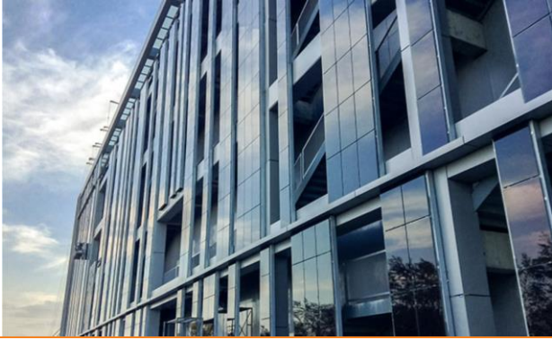
图 36：上海南侨食品有限公司项目（56.55kWp 薄膜组件 BIPV）
