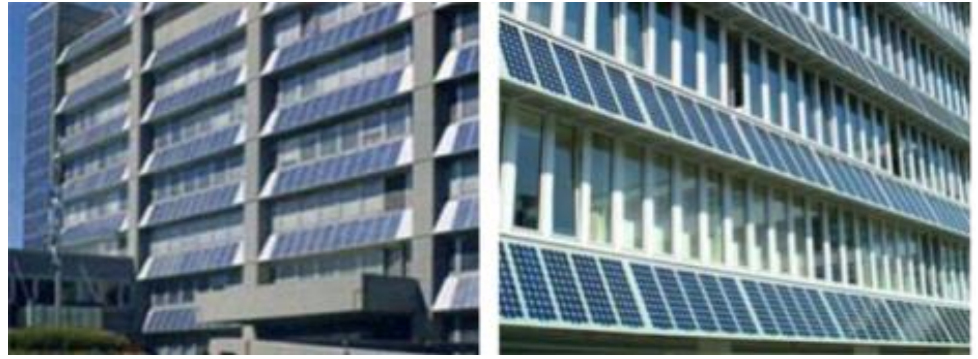
图 10：光伏组件与建筑遮阳结合示意图
