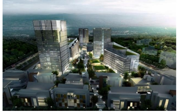
图 41：公司精品幕墙项目：杭州天安数码城富春硅谷
