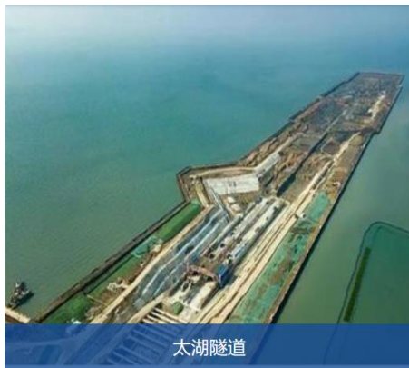
图 7：抗裂防渗剂用于太湖隧道图示
