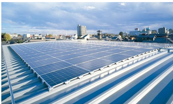
图 94：光伏仓库屋顶
