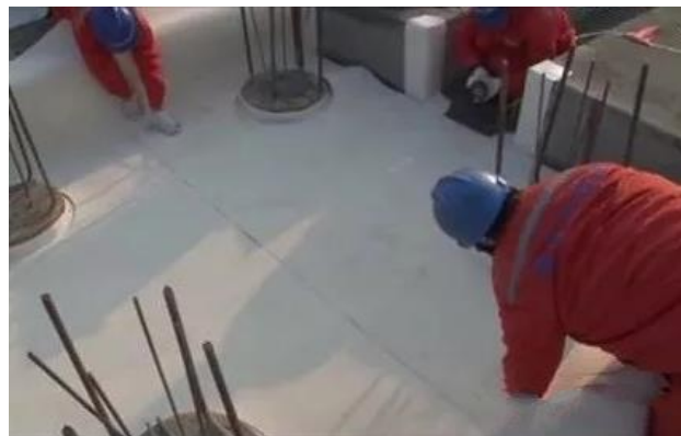
图 4：高分子卷材施工方法：冷粘法
