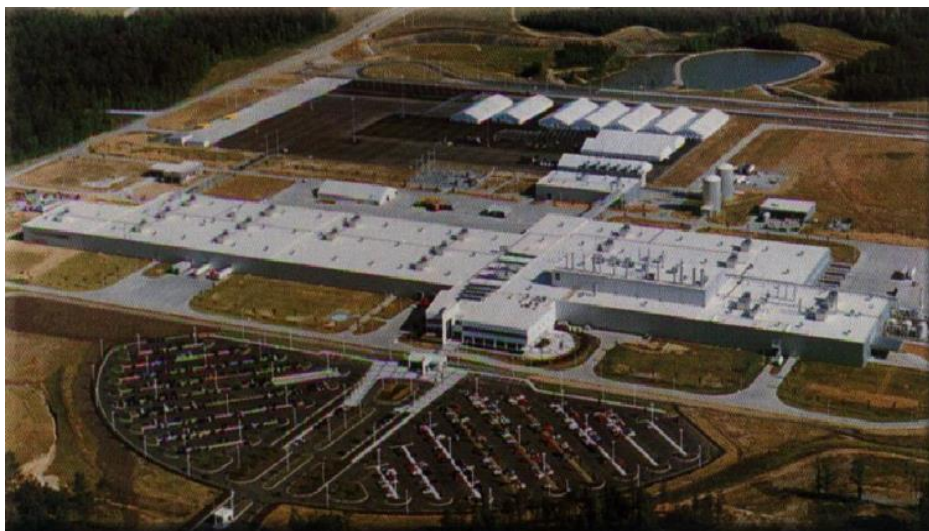
图 30：采用 TPO 屋顶防水的典型工程——美国阿拉巴马州奔驰工厂
