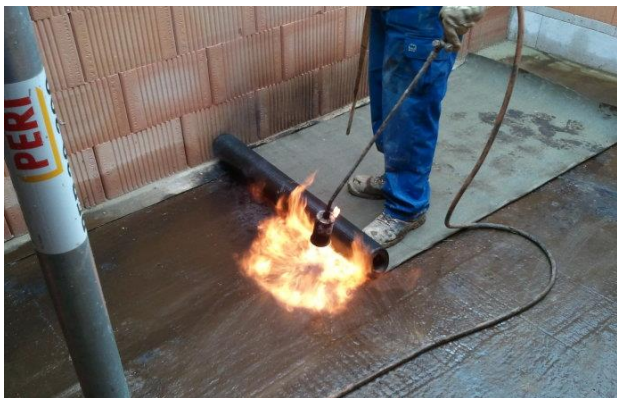
图 3：沥青基卷材施工方法：热熔法
