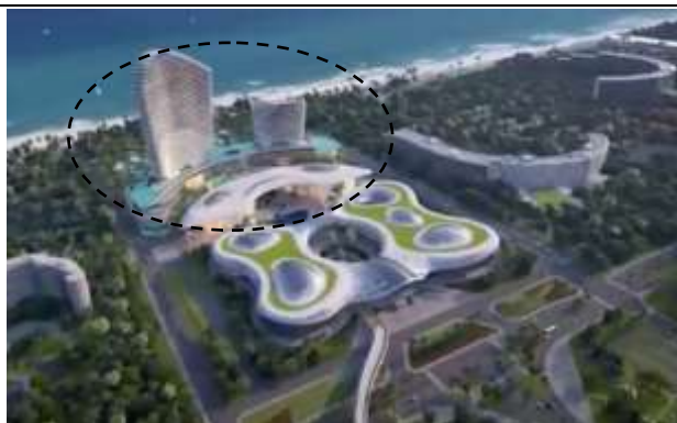
图 12：三亚 1 期 2 号地项目鸟瞰图（虚线为 2 号地）
