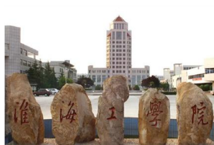
淮海工学院配电工程施工 和设施安装项目
