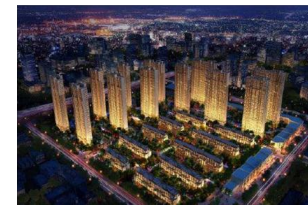
路劲地产城市印象三期配电工程
