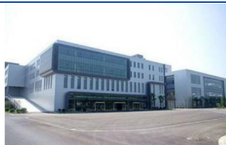
车和进标准厂房10kV变电所工程
