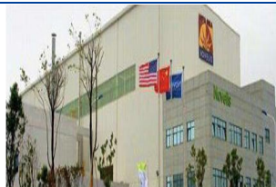
诺贝丽斯(中国)35/20kV 变电站工程
