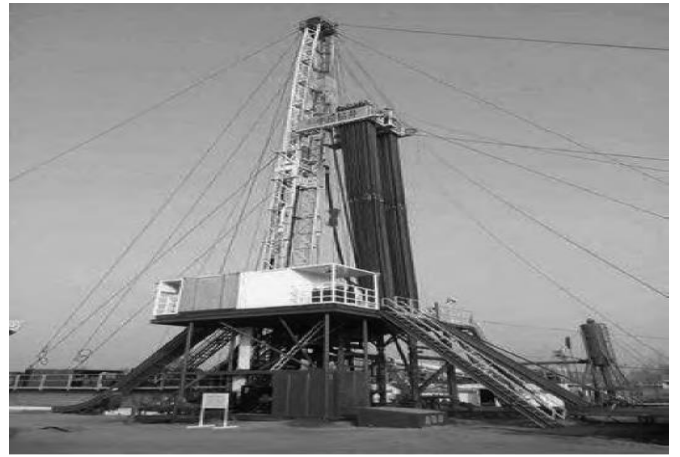
图42: 配备超级电容储能系统石油钻井机
