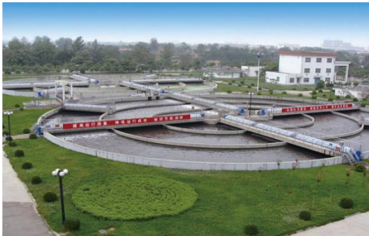
济宁市污水处理厂污水深度处理工程
