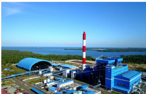
印尼 Kaltim-2 电站项目
