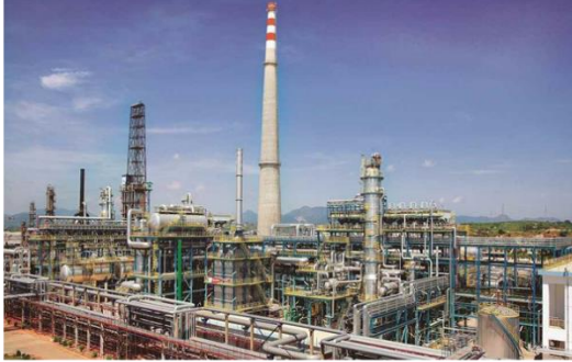
福建炼油乙烯一体化项目
