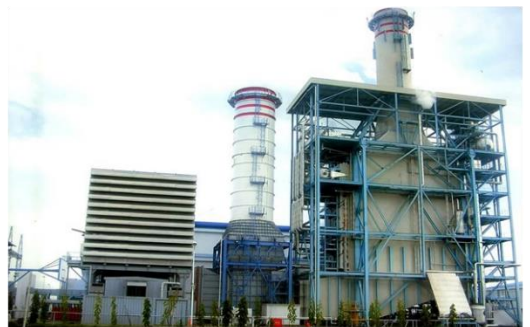
印尼巨港电站项目
