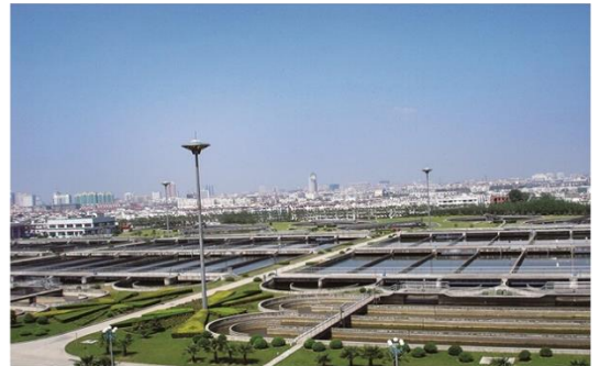
合肥市王小郢污水厂
