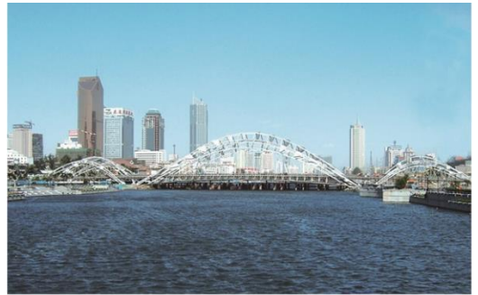
天津海河特大桥钢结构制作安装工程
