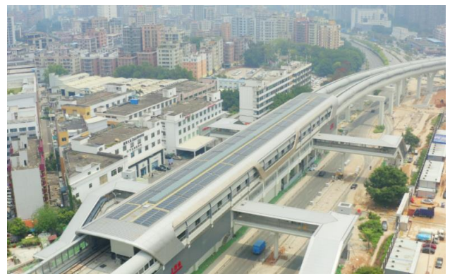
图 16：深圳地铁 6 号线高架段车站顶部分布式光伏发电系统
