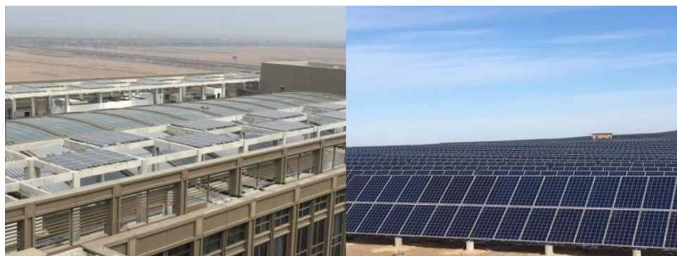
图 34：公司光伏 EPC 项目案例
