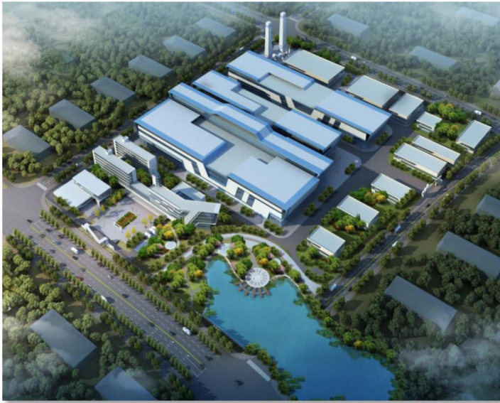
图 14：车用锂电正极材料产业化及环保技改项目工程
