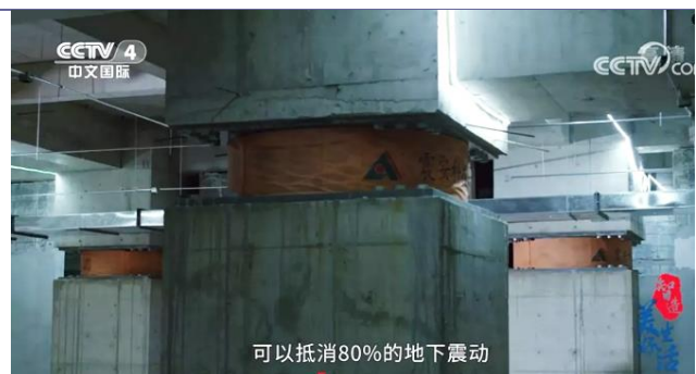
图表 4：隔震橡胶支座
