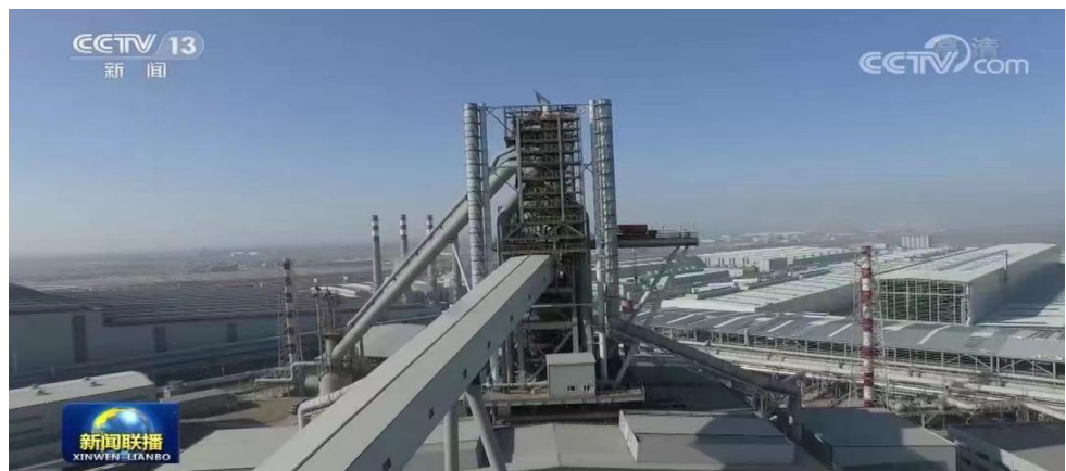
图 36: 八一钢铁富氢碳循环高炉试验项目
