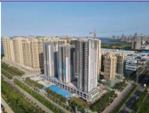
图 10: 湛江市东盛路公租房项目
