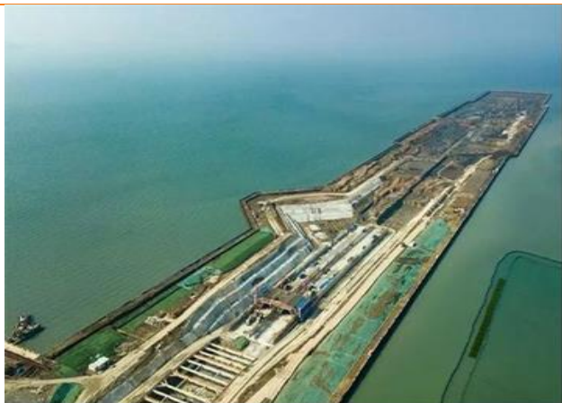
图 46：防渗抗裂材料应用于太湖隧道
