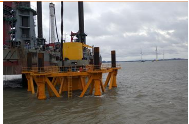
图 47：风机基础灌浆料应用于龙源莆田南日岛海上风电场
