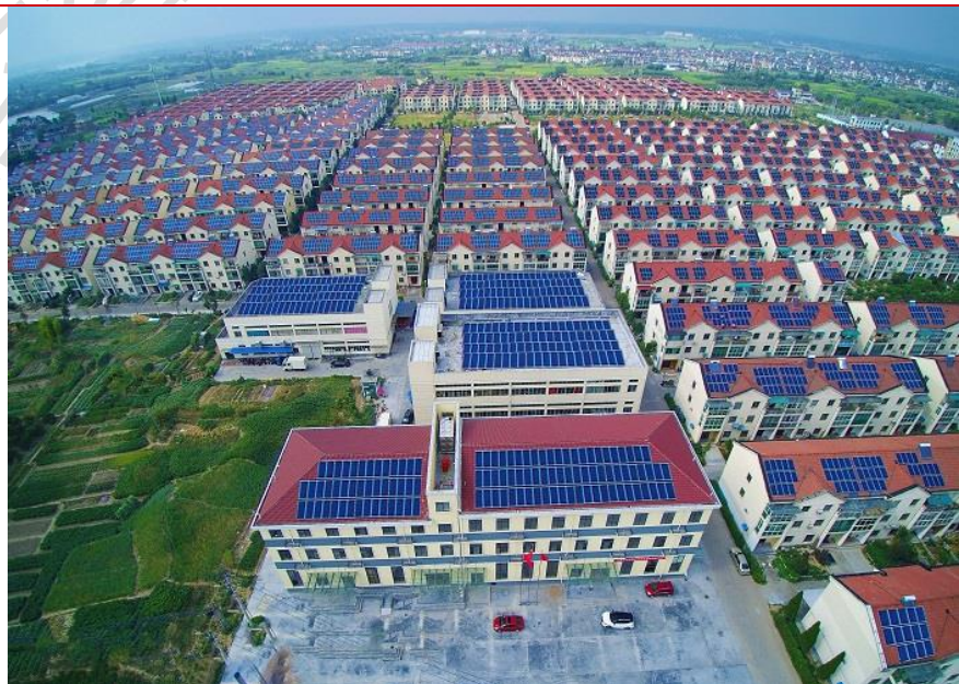
图 42：正泰户用光伏经典案例-浙江龙游县芝溪家园
