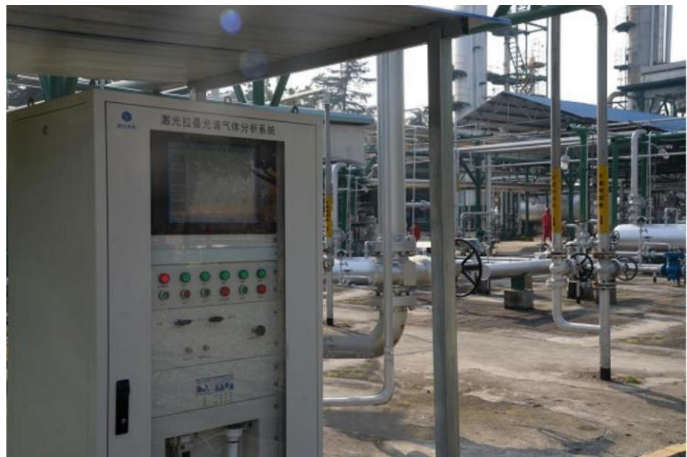
图 22：激光拉曼光谱分析仪在天然气净化厂分析原料气
