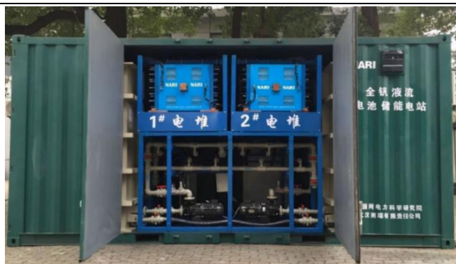
图 6：国电南瑞集装箱型钒电池储能电站已实现应用
