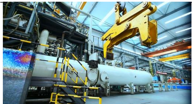
图表 7：公司 2400KW 电子束冷床炉
