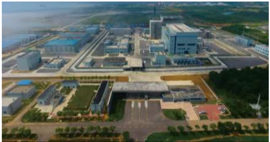
图 1：山东石岛湾高温气冷堆示范工程现场
