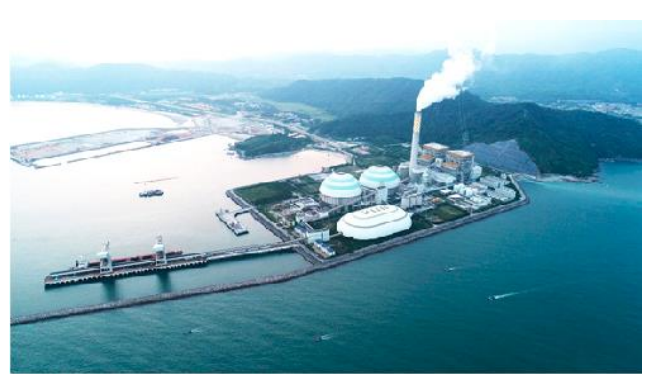
图 73：中国能建广东院总承包建设的广东碳捕集测试平台
