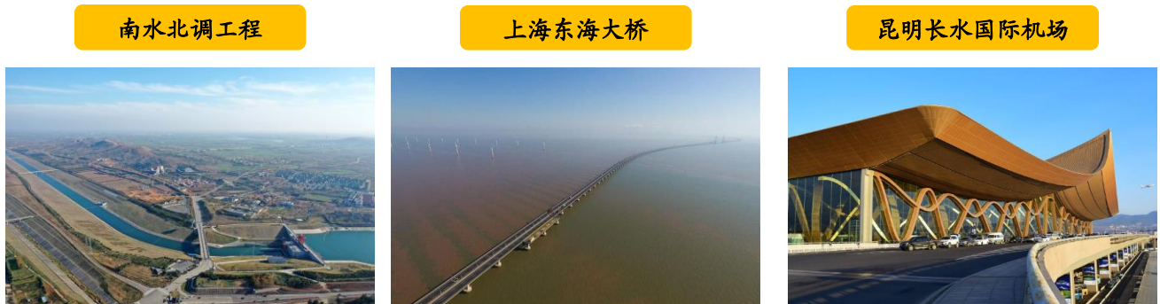
图 13：公司非电工程建设代表性项目
