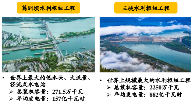
图 59：公司承建葛洲坝、三峡两大世界级水电站
