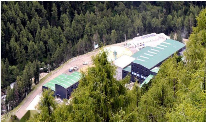
图16：阿坝业隆沟锂辉石矿采选工程
