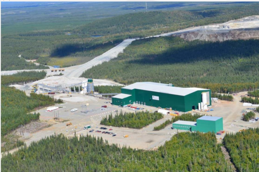
图26：NAL厂房设施现状
