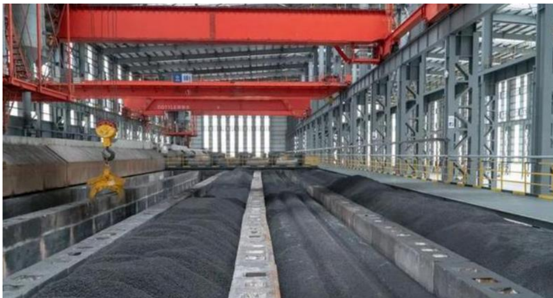
图表3 石墨化车间现场图
