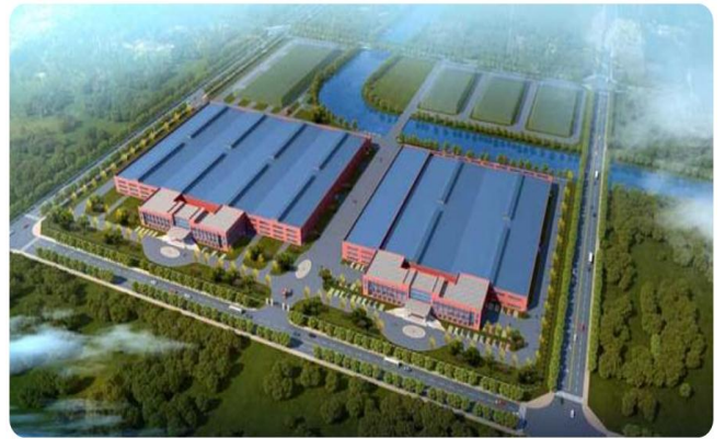
图 24: 哈特福德压缩机数字工厂全景
