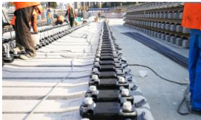
图 36: 科博思双层非线性减振扣件在苏州 3 号线的应用
