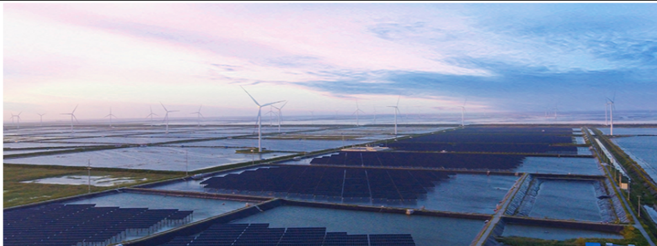
图 61: 通威江苏如东“渔光一体”项目
