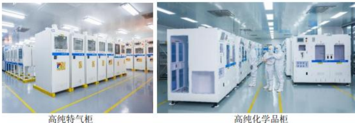
图表 2：至纯科技高纯特气柜和化学品柜
