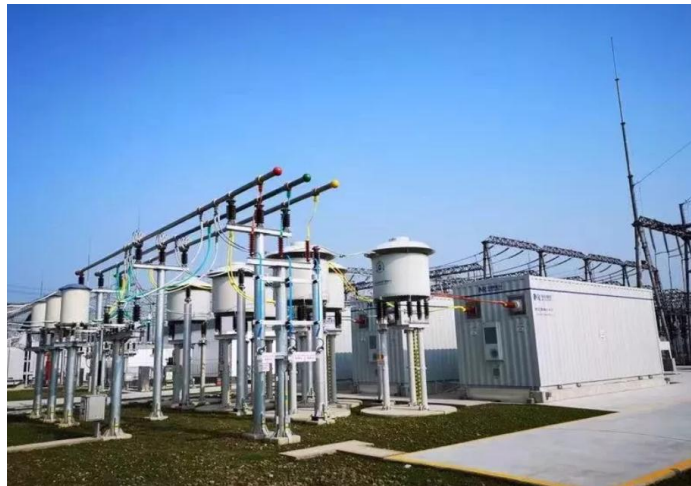
图39：世界容量最大的基于 IGBT 的静止同步补偿器
