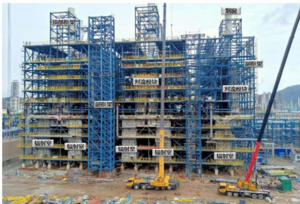
图27：乙烯裂解炉安装示意图
