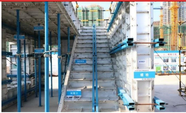
图 5 常用住宅铝模板构件
