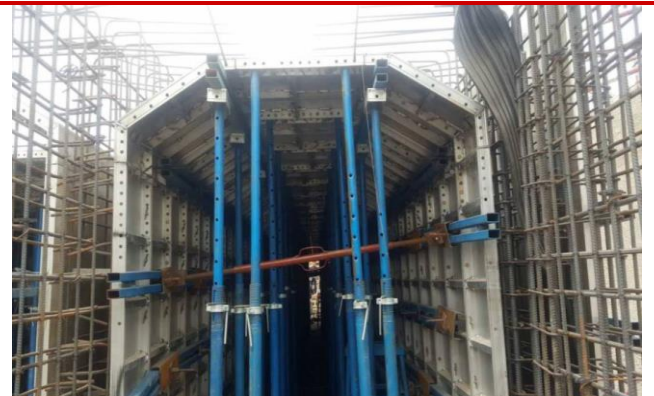
图 6 常用基建铝模板构件
