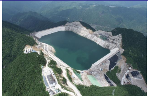
图 7：长龙山抽水蓄能电站航拍
