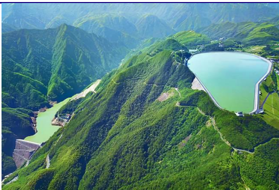
图 4：河北丰宁抽水蓄能电站上下水库
