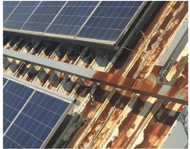
图表 11. 金属光伏屋顶寿命不及光伏部件寿命
