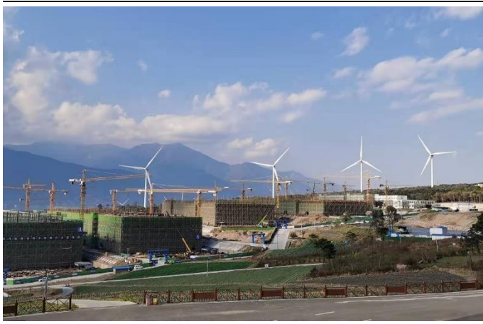
图17: “德昌项目”工程建设主体已临近封顶
