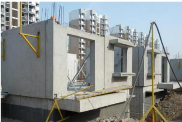
图 28: 混凝土装配式
