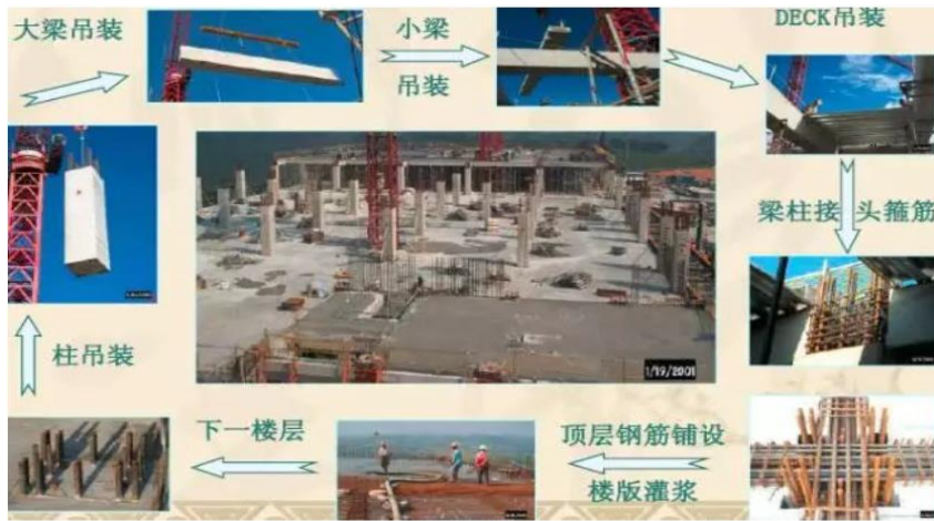
图 26: 装配式建筑施工程序
