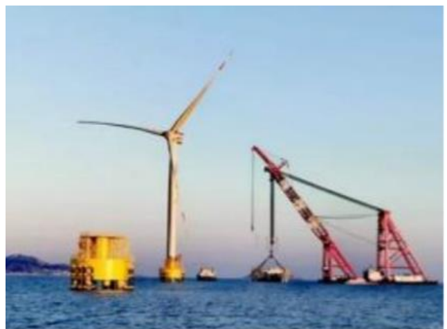
图 72：“亨通一航”号海上风电作业平台
