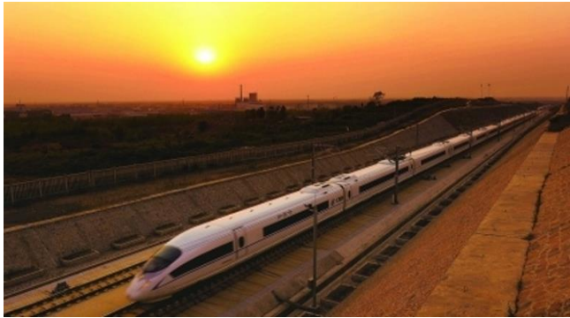
图23：公司铁路专用减水剂应用于京沪高铁建设
