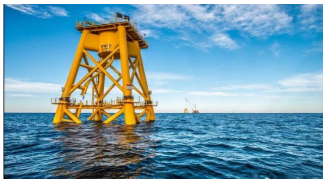
图34：导管架式为海上风电机组固定式支撑结构的一种
