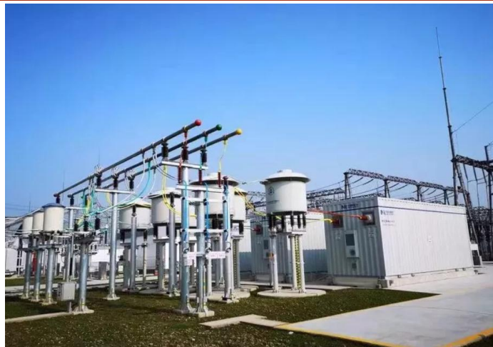
图20：世界容量最大的基于 IGBT 的静止同步补偿器
