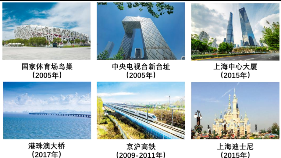
图21：公司承包多个国家大型知名建筑项目的防水工程
