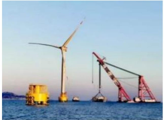
图 41：“亨通一航”号海上风电作业平台
