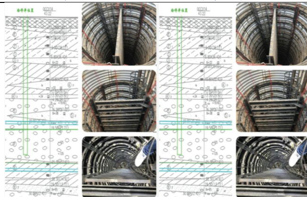
图 16 其他产品-装配式基坑支护（北京中地盾构）
