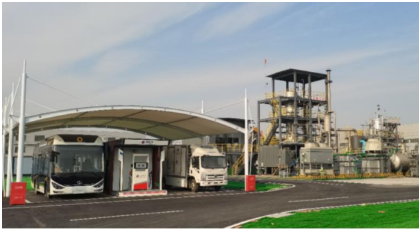
图 44：五环公司的高温垃圾气化制氢油及氢能产业示范基地
