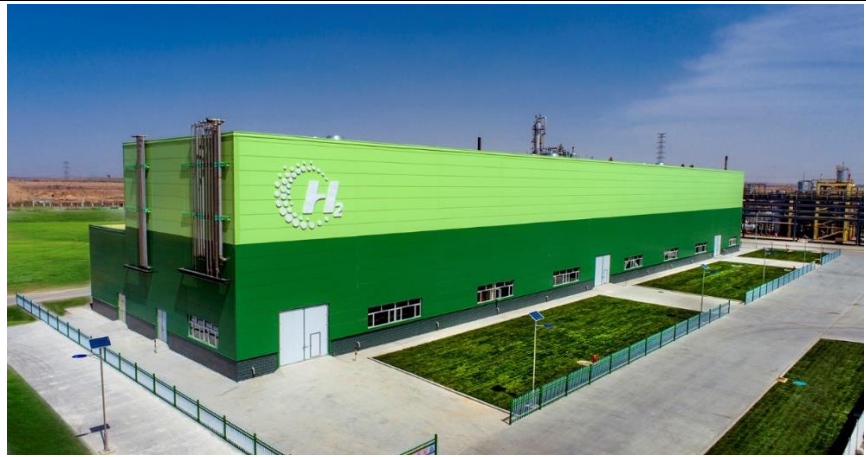
图47：宝丰能源国家级太阳能电解水制氢综合示范项目发电成本控制在 0.068 元/度
