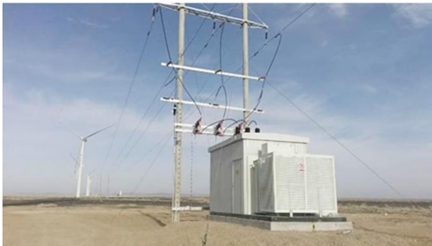
图21：“塔外箱变”方式示意图
